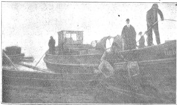
Abb. 4. Auflegen der Betongewichte vor der Absenkung. (21. Dezember 1924.)
