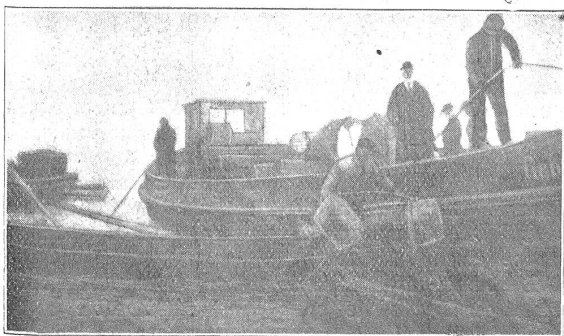
Abb. 4. Auflegen der Betongewichte vor der Absenkung. (21. Dezember 1924.)
