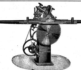
Obige 2 automatischen Sägenschärfmaschinen sind zum Schärfen von Gattersägen, Bandsägen und Fräsen konstruiert. Unerreichbar in Solidität und Leistungsfähigkeit; Modell 1920 ist noch extra zum Schärfen enger Zahnungen wie Bandsägen und kleiner Fräsen in Schreinereien sowie für Eisenfräsen in mech. Werkstätten konstruiert. Unterzeichneter liefert auch Schmirgelscheiben, nur beste Sorten, sowie Leder- und Baumwollsaiten, beste Qualität
