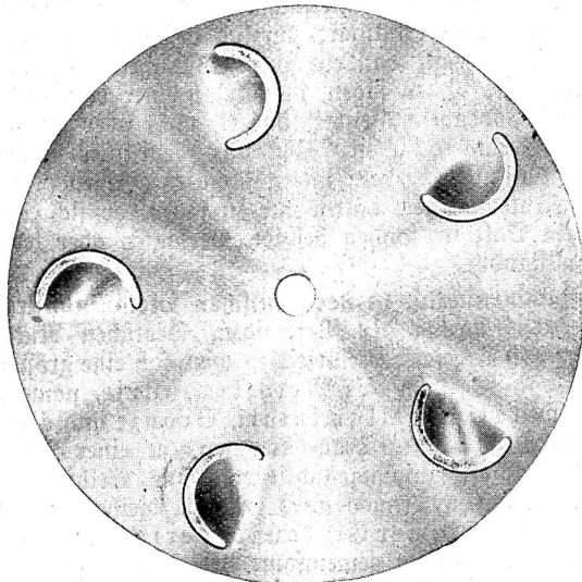
Die neue Schälscheibe kann auf jeder Tischkreissäge oder Brennholzfräse verwendet werden. Sie wird einfach an Stelle des Kreissägeblattes eingespannt, wobei man
