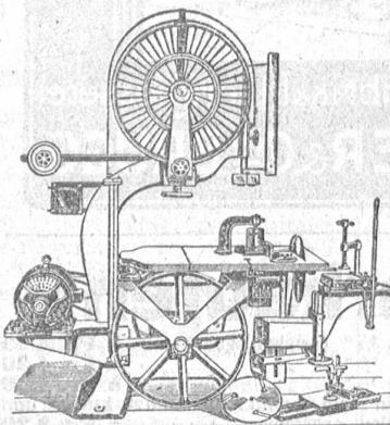
65, 70, 80 cm Rollendurchmesser mit angebautem Elektromotor. 348
