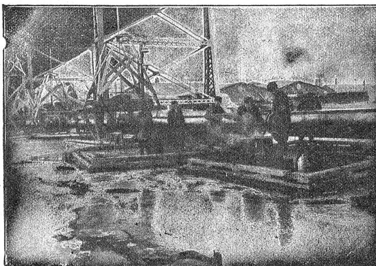
Verlegung eines Dükers aus Flanschenröhren von 600 mm I.W.
