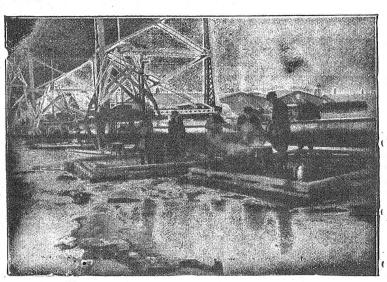
Verlegung eines Dückers aus Flinschenröhren von 600 mm l. W. In Klaraviken, Wasserleitung STOCKHOLM.
