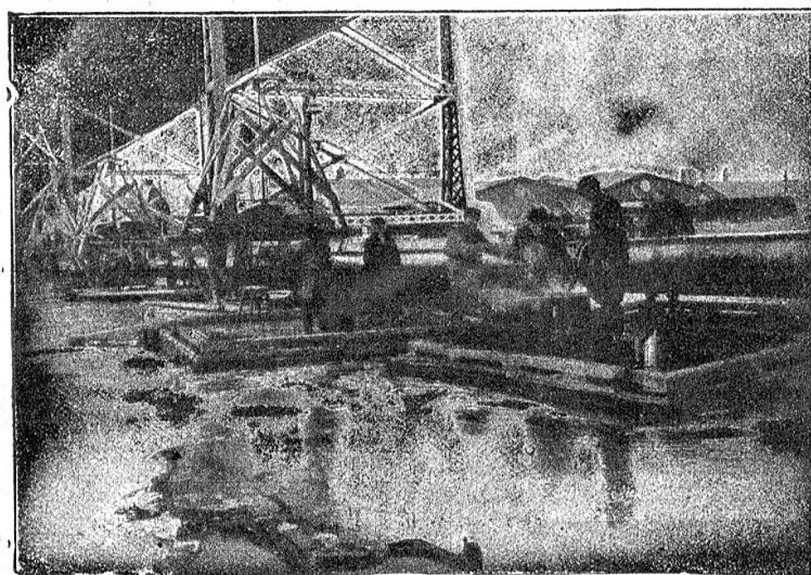
Verlegung eines Dükers aus Flinschenröhren von 600 mm l. W.
