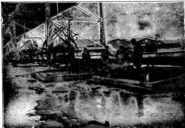
Verlegung eines Dükers aus Flinschenröhren von 600 mm I. W.
