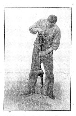
Bild 1. Eleftrischer Stampfer für Beton, Zementwaren usw.
