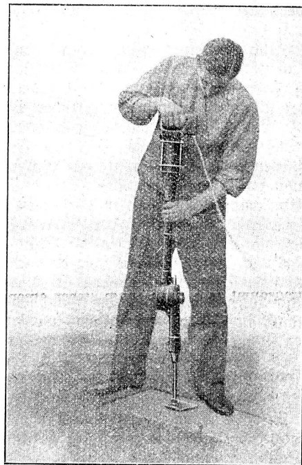
Bild 1. Elektrischer Stampfer für Beton, Zementwaren usw.
