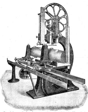
Bandsäge mit Laufwagen mit selbsttätigem Vorschub.
