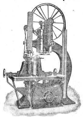
Trenn-Bandsäge mit selbsttätigem Walzeneinzug.
