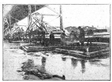
Verlegung eines Dückers aus Flanschenröhren von 600 mm I. W., in Klaraviken, Wasserleitung STOCKHOLM.
