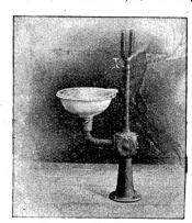
Fig. 6. Seitenansicht einer einseitigen Anlage mit Becken von 460 mm o außen emailliert
