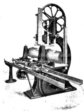
Bandsäge mit Laufwagen mit selbstfätigem Vorschub.
