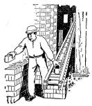
Fig. 3. Befort erung ber Steine bei hohem Gefalle.
