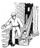
Fig. 3. Befort erung der Steine bei hohem Befalle.
