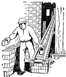
Fig. 3. Beförderung der Steine bei hohem Gefälle.
