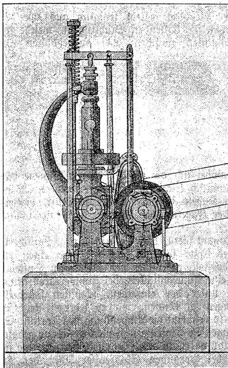
Eine der ersten Anwendungen dieses Regulators besteht in Olivone (Tessin) und zwar für eine Francis-turbine mit horizontaler Achse, welche nebst einer Gattersäge, einer Zirkularsäge und mehreren anderen Holzbearbeitungs-Maschinen eine Dynamo-Maschine, welche ruhiges Licht abgibt, antreibt.
