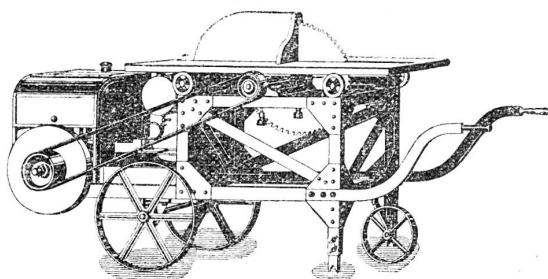
Fahrbare Kreissägen mit Benzинmotoren
