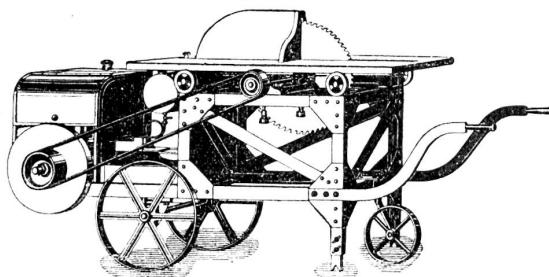
Fahrbare Kreissägen mit Benzinmotoren
