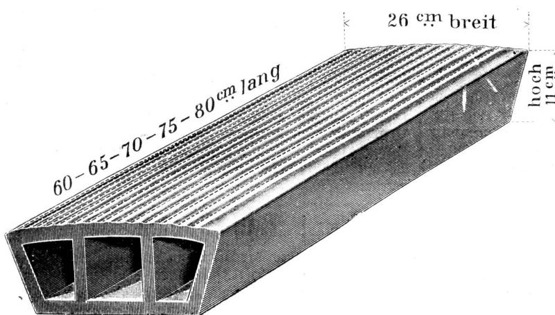
Eichenschwellen oder Zementlager dienen, worauf die Platten in Abständen von 1 cm gelegt und gut verspannt werden. Ist die Sache richtig gemacht, so ist ein Aufbrechen durch die Schweine absolut unmöglich, und man hat einen Boden der dauerhaft, trocken und gut zu reinigen ist, mit viel weniger Streuebedarf, als
