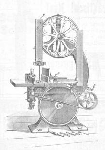
Bandsäge kombiniert mit Kehlmaschine.
