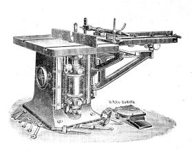
Kombinierte Kehl- und Zapfenschneidmaschine.
