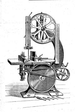
Bandsäge kombiniert mit Kehlmaschine.
