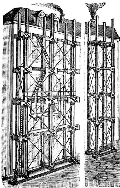
Richtung erhöhte Sicherheit zu bieten, ist an und für sich beachtenswert, und das auf der Ausstellung von einem Chemnitzer Fabrikanten erstellte Gerüst mit allseitig diagonaler Verspannung, die leichte Errstellungsweise und gute Fügung desselben scheinen nach jeder Richtung eine glückliche Lösung dieser für die Sicherheit der Baumannschaft überaus wichtigen Frage zu bedeuten.
