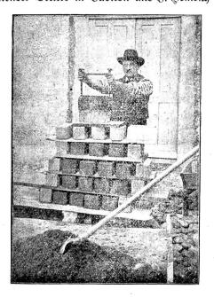
Rotenstein, Dürnten, Zürich. Handgerät zur Herstellung von Kunststeinen. Die bishergebräuchlichen Pressen zur Herlen zur Herstellung von Kunststeinen haben eine relativ komplizierte maschinelle Einrichtung, welche deren leichte und bequeme Transportsähigkeit erschwert, und ihre stationäre Aufstellung bedingt, auch ersordern dieselben zu ihrer Besteinung gewöhnlich mehrere Arbeitskräfte.
