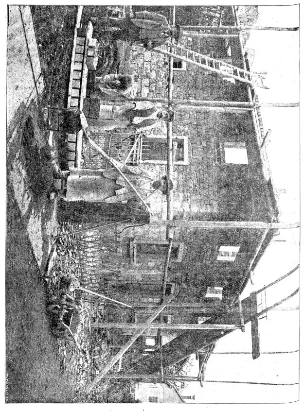
und Eisen. Die Balken und nötigen Trischübel des Baues sind 15 cm hohe Eisen-T-Balken, welche mit Cementheton ausgegolien wurden
