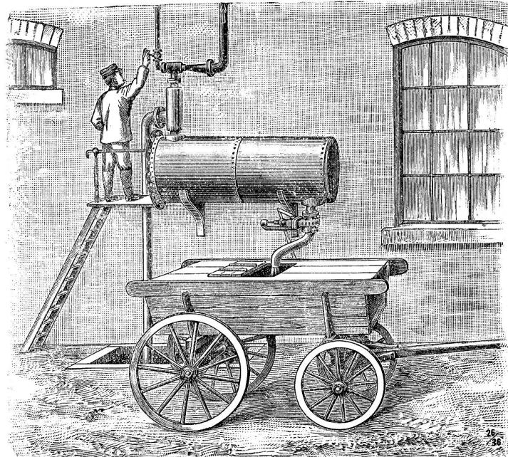
über dem Erdboden angebracht, daß sein Inhalt in einen untergeholbenen Wagen frei abfließen kann. Der selbe, zweckmäßig aus Eisen angefertigt, ist mit einem Dampfstrahlrohr, sowie mit einer nach der Grube führenden Saugleitung fest verbunden. Die Ablauftleitung, die zum Transportgefäß führt, ist durch einen
