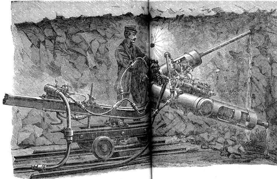
Suramptunnel (Raukofus) wo der mittlere Tagesfortschritt der ganzen Bohrung 5,98 Meter betrug und der monatliche Fortschritt während 7 Monaten zwischen 195,8 Meter im Minimum, 232,1 Meter im Maximum variierte, dabei gelangten immerhin nur vier Bohrmaschinen zur Anwendung, während bei den am höchsten forcirten Leistungen mit Perkussionsmaschinen acht bis neun Maschinen zur gleichzeitigen Verwendung kommen.
