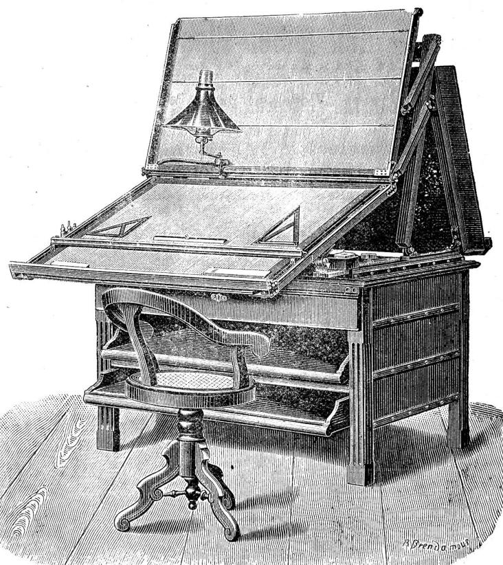
binierten Zeichendreiecken, welche alle Winkel mit den Abstufungen von 15 Grad enthalten, auch jede beliebige schiefe Parallel-Projektion und zu gleicher Zeit durch Umdrehung der Zeichendreiecke deren zugehörige senkrechte Projektion ausgeführt werden.
