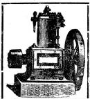
Unbedingt zuverlässiger und ruhiger Gang. Betrieb mit ge wöhnlichem Lampenpetroleum (kein Benzin). Schmierung durchaus selbstthätig ohne Schmiergefässe, daher wenig Wartung, grosse Oelersparnis. Grösste Dauerhaftigkeit, einfachste Konstruktion Konsum der Petroleum-Motoren eirea 0,4 bis 0,6 Liter gewöhn-liches billiges Lampenpetroleum pro Pterdekraft und Stunde
