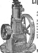
(System Capitaine). Vorzügliche, gut durch-dachte Konstruktion, in über 4000 Exemplaren verbreitet. Inbetriebsetzung innert 8 Minuten. Petrolverbrauch Minuten nur ½ Liter per Pferdekraft-stunde. — Beste Verbrenn-ung der Gase, daher geringster Geruch. Ruhiger, gleichmässiger Gang. Solider Bau. Billigste Betriebskraft. [108
