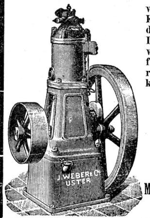
vorzüglich, bewährtester Konstruktion (System Swiderski Capitaine, patentiert). In mehr als 3000 Exempl. verbreitet, feststehend und fahrbar, (Lokomobile). Geringst. Petroleumverbrauch, kürzeste Inbetriebsetzung, kleinster Raumbedarf, solider Bau. 85
