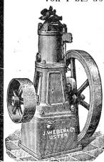
vorzüglicher, bewährtester Konstruktion (System Swiderski Capitaine, patentiert). In mehr als 3000 Exempl. verbreitet, feststehend und fahrbar, (Lokomobile). Geringst. Petroleumverbrauch, kürzeste Inbetriebsetzung,
