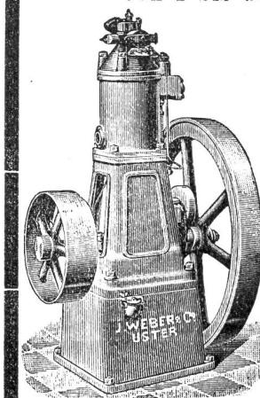
vorzüglicher, bewährtester Konstruktion (System Swiderski Capitaine, patentiert). In mehr als 3000 Exempl. verbreitet, feststehend und fahrbar, (Lokomobile). Geringst. Petroleumverbrauch, kürzeste Inbetriebsetzung, kleinstter Raumbedarf, solider Bau. 85
