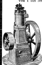
vorzüglicher, bewährtester Konstruktion (System Swiderski-Capitaine, patentiert). In mehr als 3000 Exempl. verbreitet, feststehend und fahrbar, (Lokomobile). Geringst. Petroleumverbrauch, kürzeste Inbetriebsetzung,
