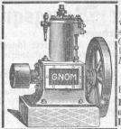
Unbedingt zuverlässiger und ruhiger Gang. Betrieb mit gewöhnlichem Lampenpetroleum (kein Benzin). Schmierung durchaus selbstthätig ohne Schmiergefässe, daher wenig Wartung, grosse Oelersparnis. Grösste Dauerhaftigkeit, einfachste Konstruktion. Konsum der Petroleum-Motoren eirca 0,4 bis 0,6 Liter gewöhn-liches billiges Lampenpetroleum pro Pferdekraft und Stunde.
