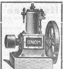
Unbedingt zuverlässiger und ruhiger Gang. Betrieb mit gewöhnlichem Lampenpetroleum (kein Benzin). Schmierung durchaus selbstthätig ohne Schmiergefässe. daher wenig Wartung, grosse Oelersparnis. Grösste Dauerhaftigkeit, einfachste Konstruktion. Konsum der Petroleum-Motoren eirea 0,4 bis 0,6 Liter gewöhnliches billiges Lampenpetroleum pro Pferdekiaft und Stunde.
