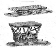
Die von den Herren A. Oehler & Cie. in Wildegg bezogenen Rollbahnschienen, Kreuzungsstücke, Drehscheiben, Kippwagen etc. haben sich äusserst solid und zweckentsprechend erwiesen.
