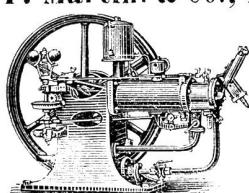
**Gasmotoren** für Leuchtgas.
