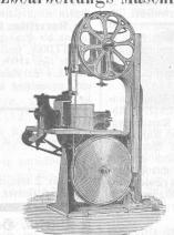
missionen. Circularsäge f. alle Zwecke, 3 Grössen. Kehlmaschinen m. horizontaler und vertikaler Achse. Sägefeilmaschinen, 2 Grössen. Universalmaschinen.
