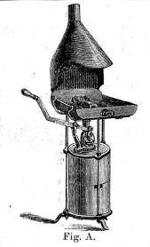
Kleine einfach- und doppeltblasende Feldschmiede mit drehbarem Hebel zum drücken oder treten. Guss-oder schmiedeiserne Esse-, Bodenund Deckelplatten.
