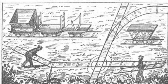
Spezialität in tragbaren Stahlgleisen für Feld-, Dienst- und Industriebahnen. Eiserne Transportwagen für Geleise, eiserne Schubkarren. Projekte und Anlagen von Fabrik-Geleisen.
