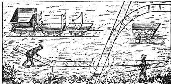
Spezialität in tragbaren Stahlgeleisen für Feld-, Dienst- und Industriebahnen. Eiserne Transportwagen für Geleise, eiserne Schubkarren. Projekte und Anlagen von Fabrik-Geleisen.
