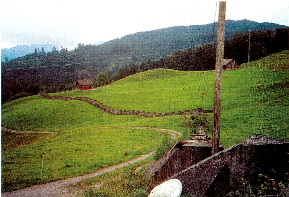
Das massive Höckerhindernis am Stoss zieht sich über eine Länge von 1,5 km hin.
