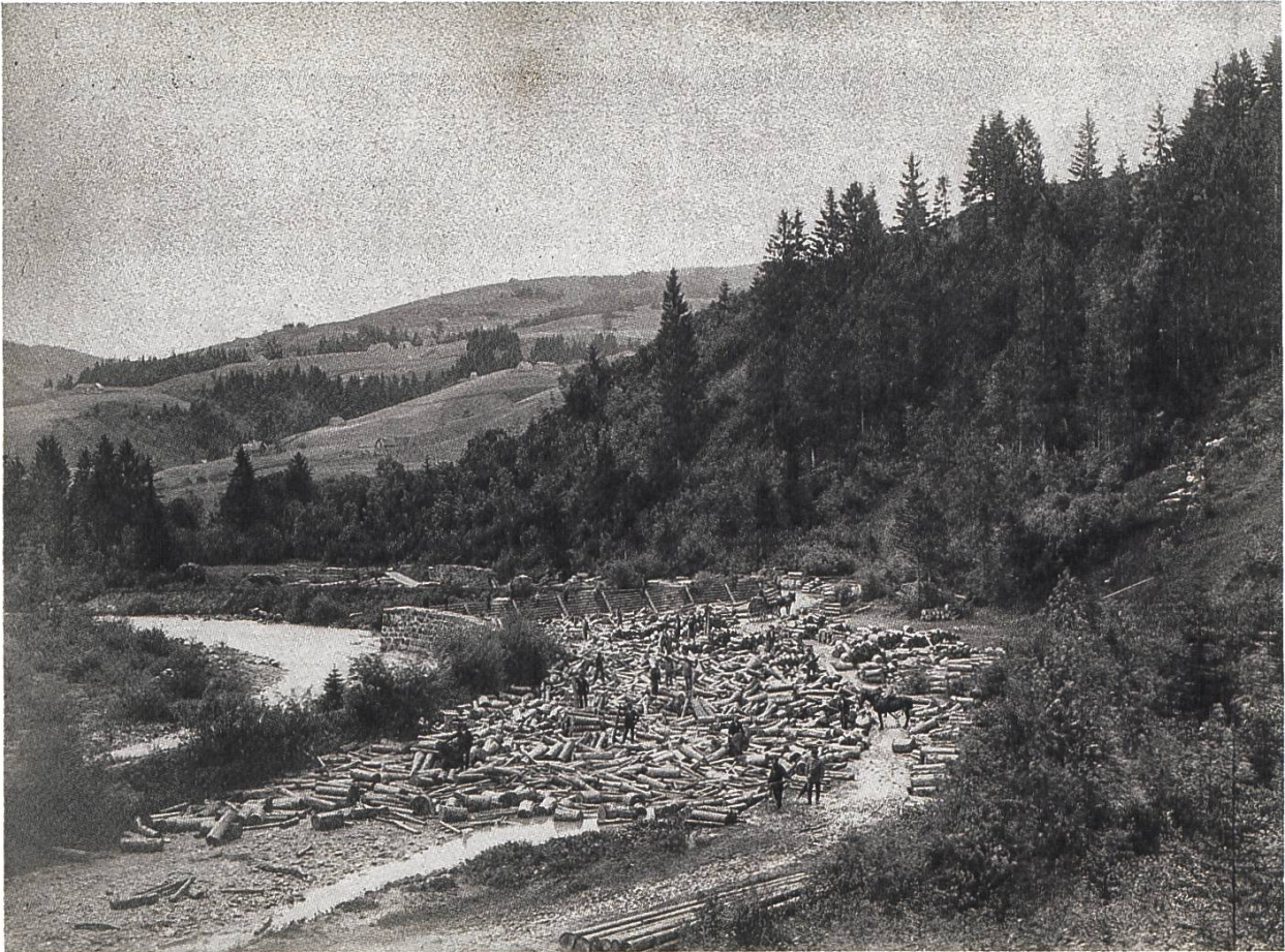
Sammelhof der Flössanlage im Glandenstein mit angeschwemmtem und bereits sortiertem Holz, um 1910. (Abb. 10)
