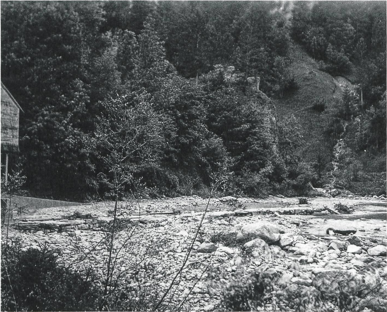
Überreste des Querwuhrs, das im August 1941 durch den Hochwasser führenden Weissbach zerstört und in Teilen wieder aufgebaut wurde. (Abb. 13)
