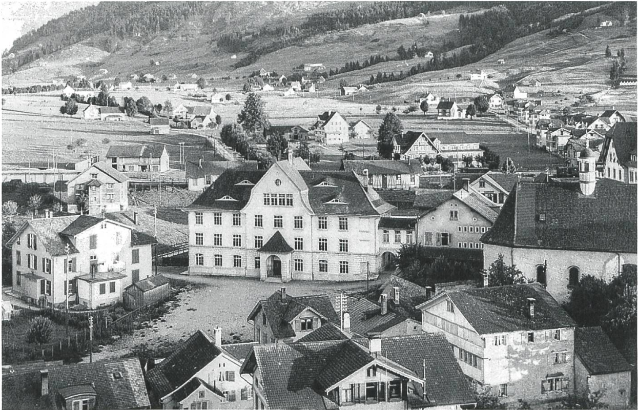
Das 1911 eingeweihte Schulhaus Chlos, kurz nach dem Neubau vom Turm der Pfarr- kirche St. Mauritius aus fotografiert. (Abb. 16)
