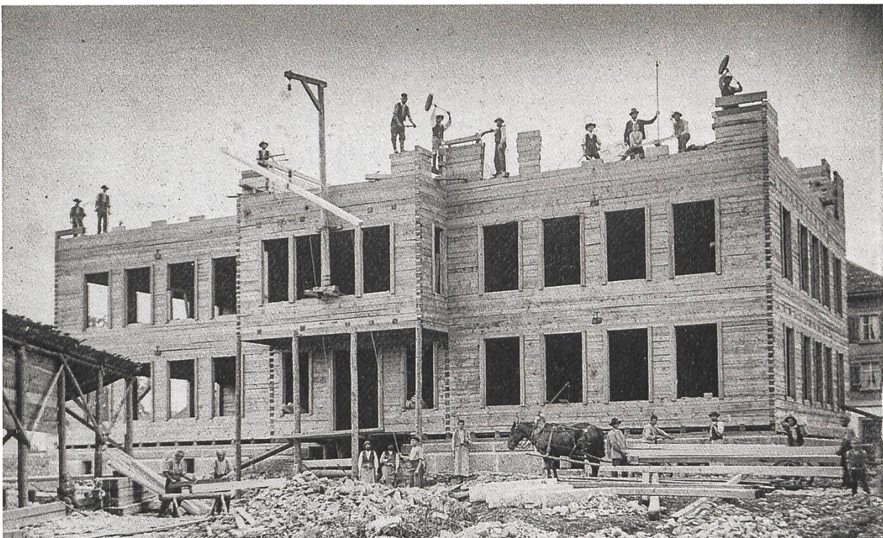
Das neue Hofwies-Schulhaus im Rohbau, 1889. (Abb. 27)
