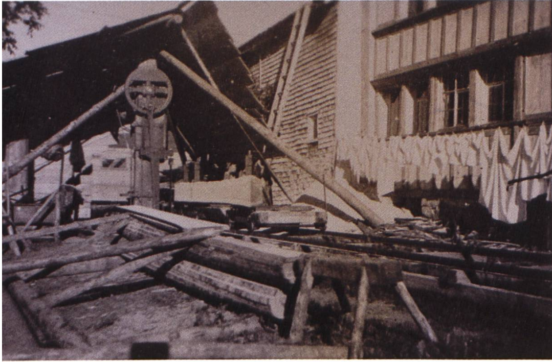
Aufgebaute Feldsäge- rei vor dem Restau- rant Saul für den Bau einer neuen Scheune, um 1945. (Abb. 16)
