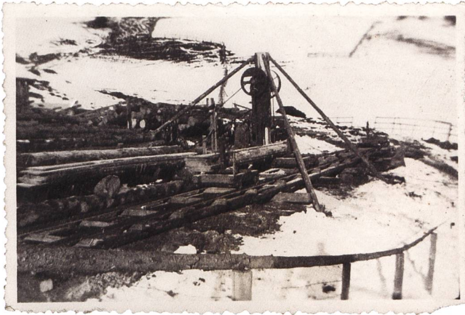
Betrieb der Feldsäge im Aussenbetrieb ohne Notdach. (Abb. 8)
