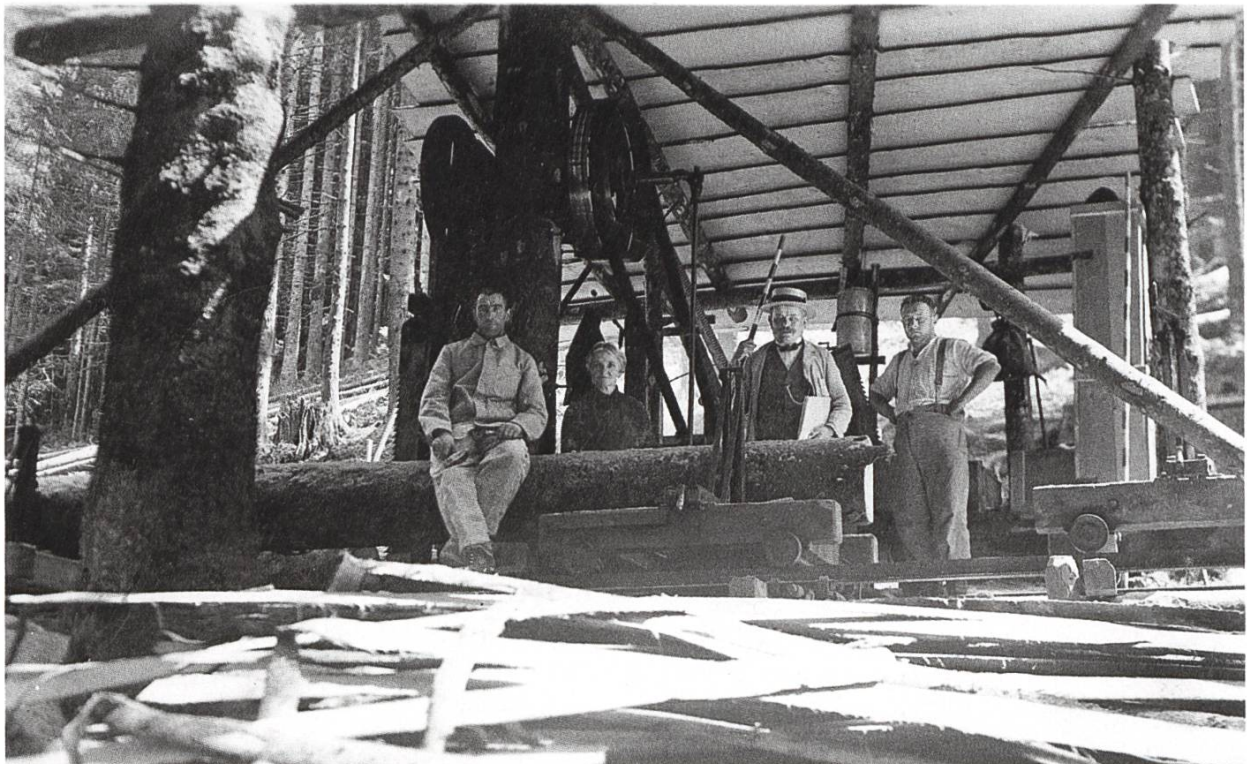
Die Kraftübertragung vom Motor auf die Säge erfolgte mittels eines Lederriemens. Abgebildet sind u.a. Andreas Broger (links) und Landes- bauherr Josef Anton Gschwend, Mettlen (mit Strohhut). (Abb. 9)
