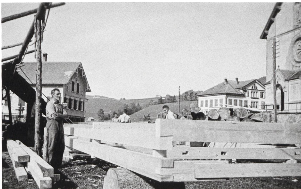
Auf dem Parkplatz des Gasthauses Krone in Brülisau wurde das Holz für das neue, im Strickbau erstellte Wohnhaus der Familie Neff, «Lochbueb», gesägt, um 1950. (Abb. 17)
