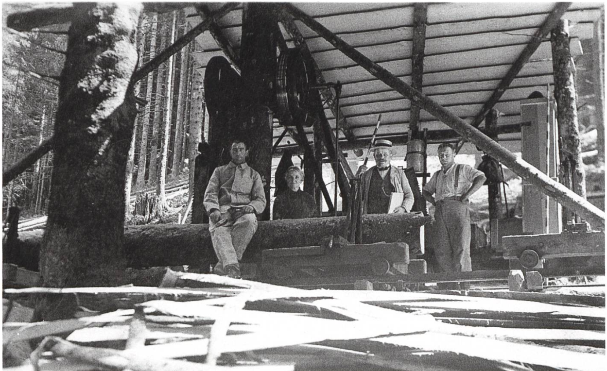
Die Kraftübertragung vom Motor auf die Säge erfolgte mittels eines Lederriemens. Abgebildet sind u.a. Andreas Broger (links) und Landes- bauherr Josef Anton Gschwend, Mettlen (mit Strohhut). (Abb. 9)
