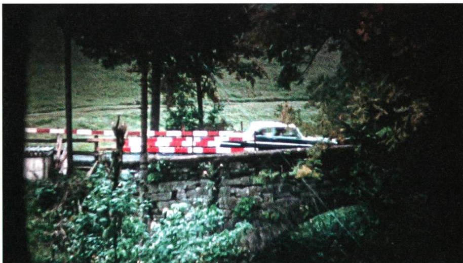
Ausschnitte aus einem Amateurfilm von Andreas Broger-Zweifel, Nesslau, über die Umleitung des Verkehrs über die alte Kesselismühlebrücke, 1969. (Abb. 14 und 15)
