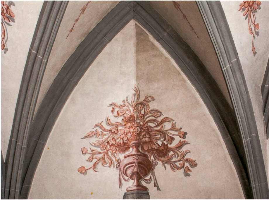
Zwischenzustandsaufnahme bei der Instandstellung des Chores. Das Gewölbe ist bereits gereinigt, gefestigt und retuschiert. Die Schildwand ist erst zur Hälfte gereinigt, so dass der Verschmutzungsgrad deutlich wird. (Abb. 4)
