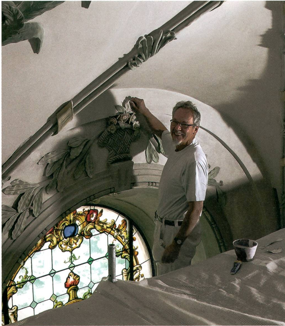
Trotz des insgesamt guten Zustandes des Gewölbes fehlten da und dort kleinere Stuckteile. Viktor Wicky, Stuckateur der Firma Knöchel und Pungitore, ersetzt ein fehlendes Blatt. (Abb. 6)
